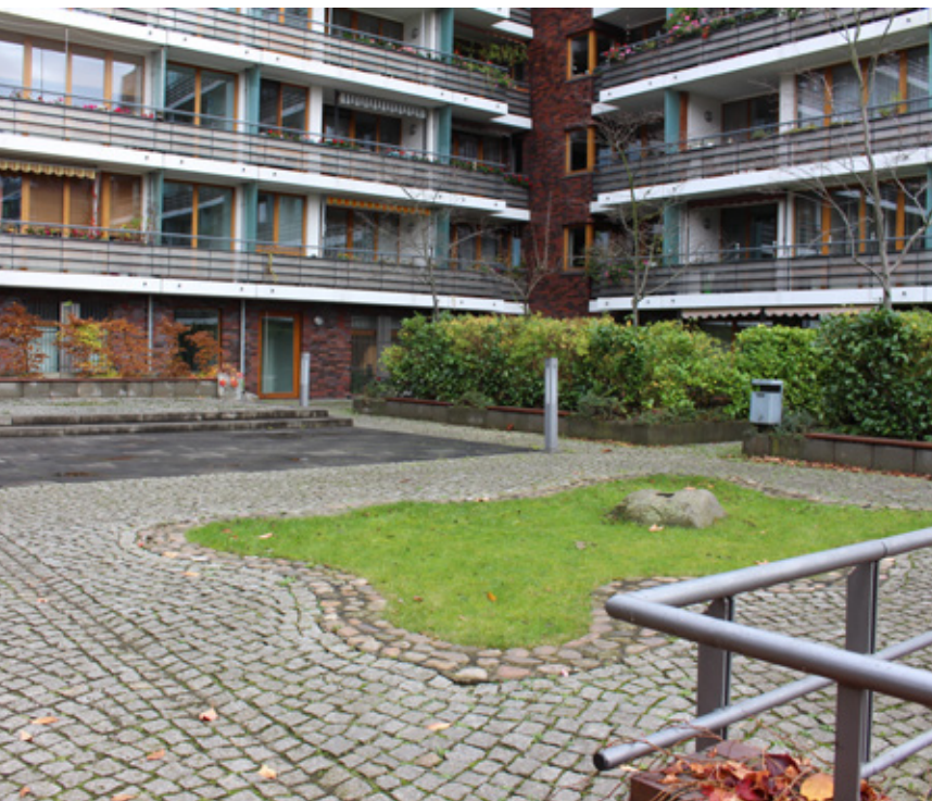
40. fotó: Vízáteresztő burkolat belső udvarban, Berlin
