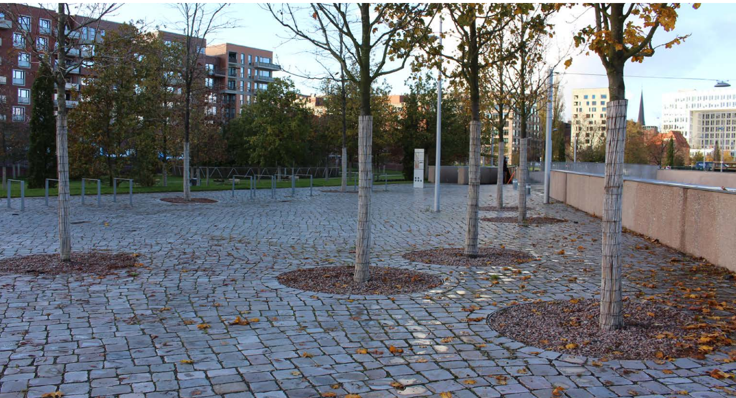
18. fotó: A kiselemez terméskő burkolat áteresztí a vizet a fák gyökeréhez, Lohsepark, Hamburg
