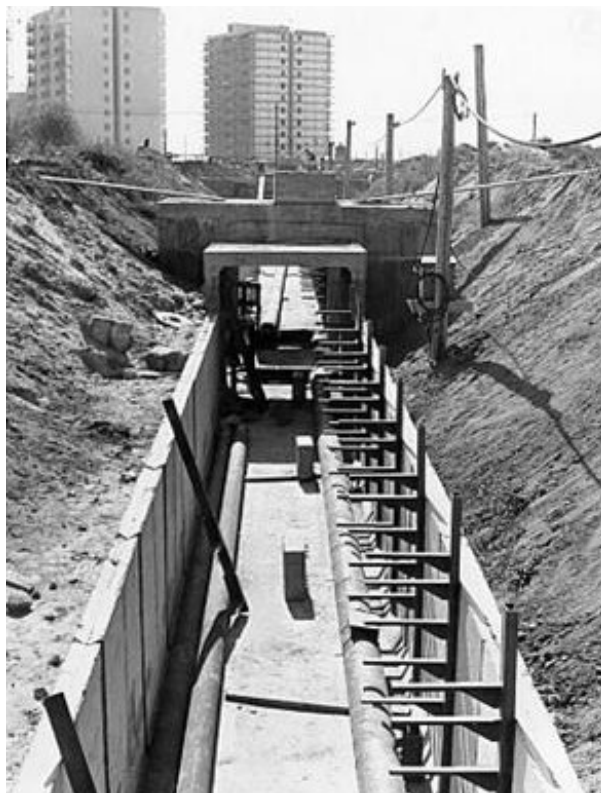
14. fotó: A pesterzsébeti közműalagút építése
