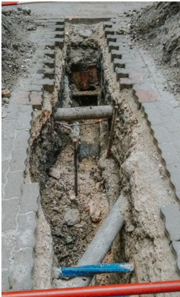
25. fotó: Gázvezeték rekonstrukció, Visegrádi utca, Budapest
