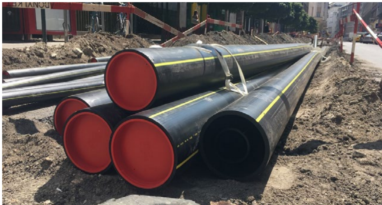
18. fotó: Gázvezeték rekonstrukció
